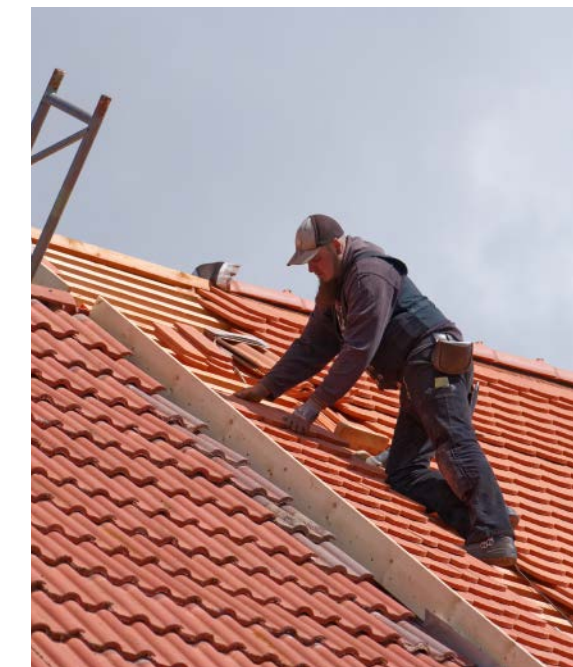
Egal ob Biberschwanz oder moderner Doppelmuldenfalzziegel: Die akkurat vermessene Lattung ist immer die Grundlage.
